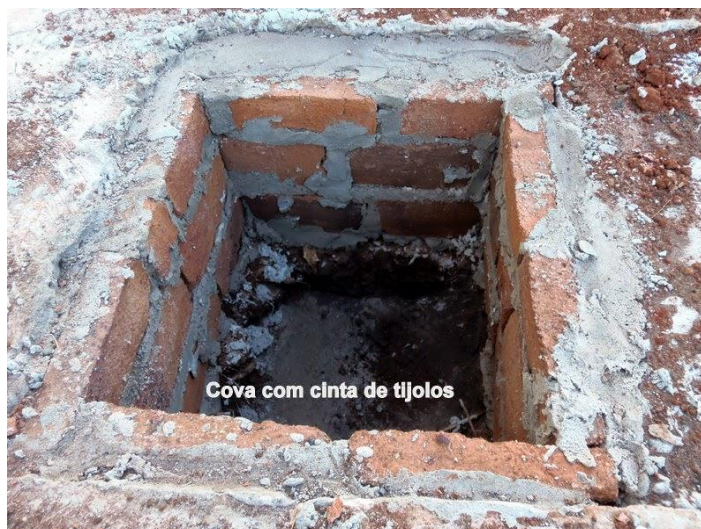
Figura 1: Modelo das covas das árvores, porém será realizado em bloco de concreto cheio.
