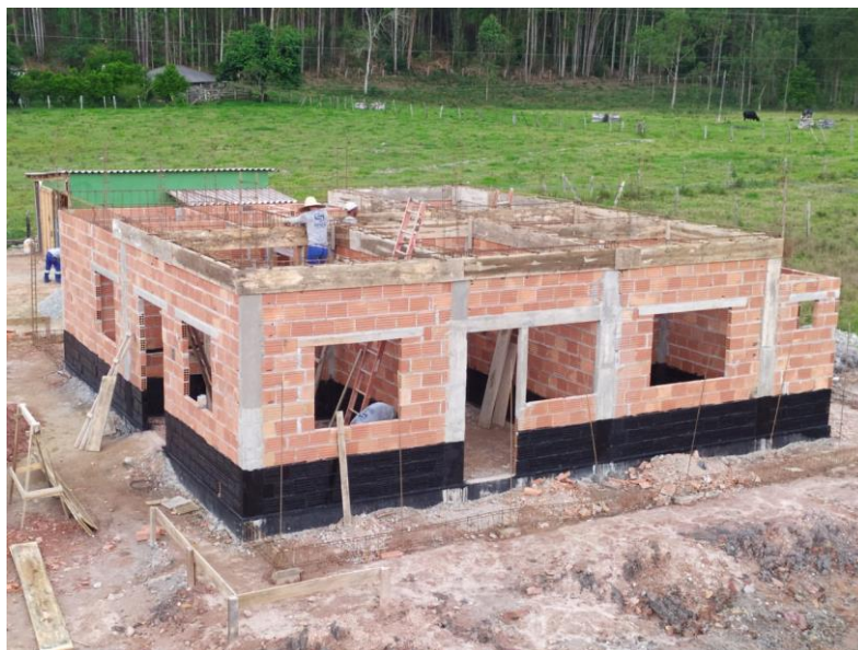
Figura 2: Impermeabilização das paredes.
